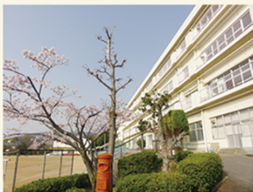
逆瀬台小学校校舎
