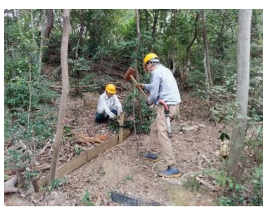
キツネの森入口に土砂止め用板設置
