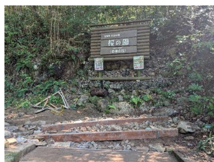
階段最上部に水抜き兼ステップ2段増設
