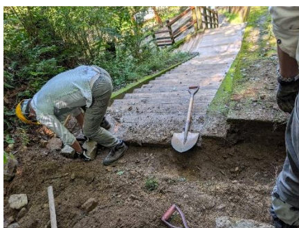
桜の園への階段最上部 排水改善の溝
