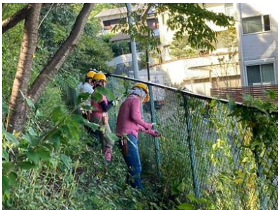
フェンスの草刈り
