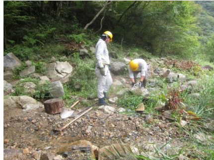
武庫川河原 整地と流路の調整作業
