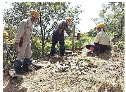
陽光展望台横階段の補修中
