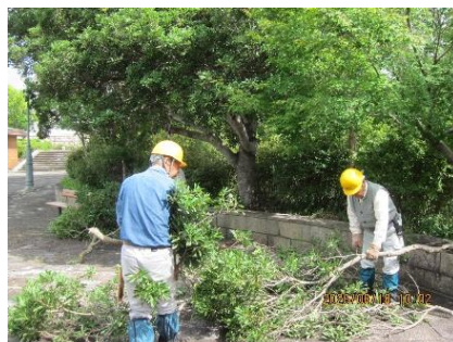
噴水広場周囲 園路に張り出した枝の伐採
