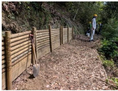
同左 本日の作業終了時点
