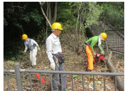
中川大橋兩岸 枯れたイヌエンジュの伐採・処理
