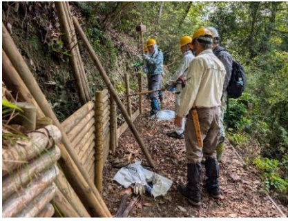
桜坂上部 丸太組土留め柵設置
