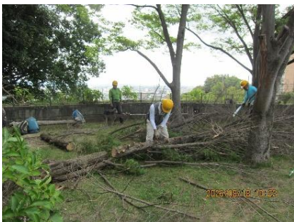
集合広場 枯れ木・枯れ枝の伐採、処理
