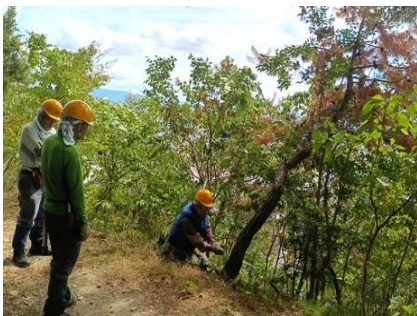
青葉台口入口通路民家側斜面の 枯れ松を伐採
