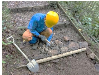
桜坂上部東屋直下での階段補修
