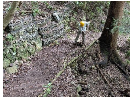
東屋・隔水亭間の園路 浮石等の除去
