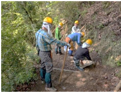
桜坂上部 土留め柵追加作業
