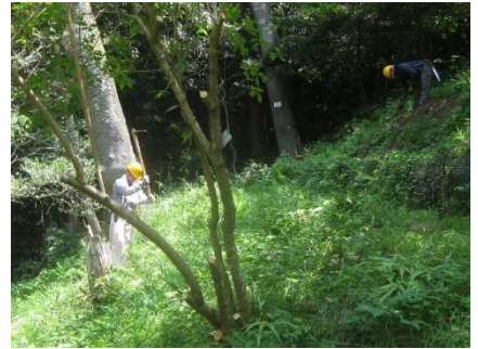
桜坂中段 桜移植用開削
