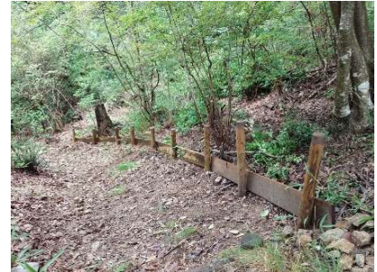
西山堰堤北上側の東西連絡路 山裾側に土砂止め板設置
