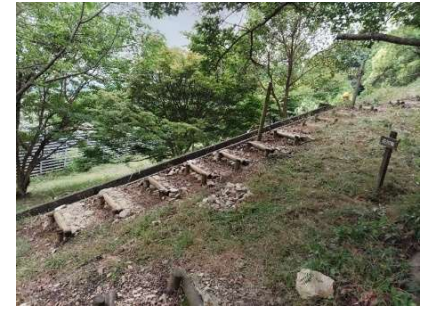
陽光展望台への階段の 木製横木、杭の更新
