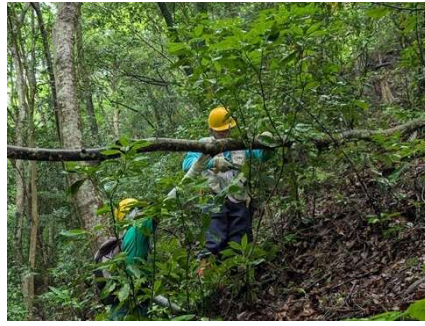
内周路点検整備 2
