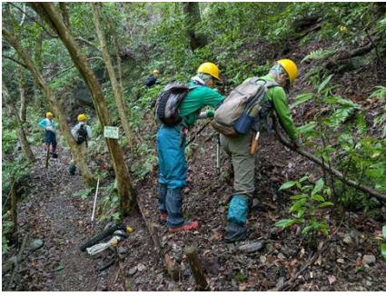
内周路点検整備 1
