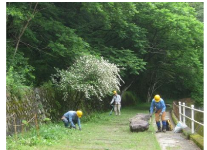
枕木の間の草も丁寧に刈取り
