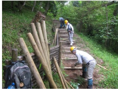
桜坂での階段増設
