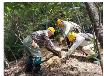
イチヤクソウの丘～西逆瀬台口間登山路の路肩改修
