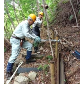
キツネの森入口階段横斜面に土砂止め板設置
