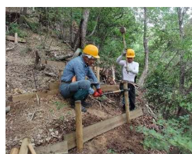
十字路～キツネの森間 園路脇斜面に土砂止め設置
