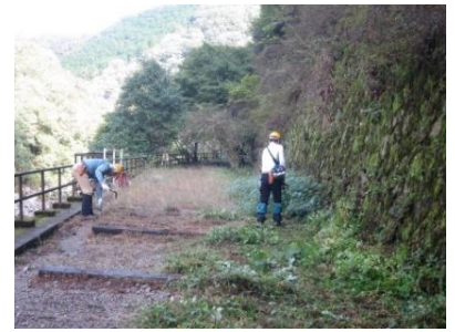
第一トンネル手前 枕木の間は手刈作業
