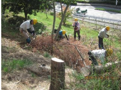
南斜面；枯れ松の伐採処理
