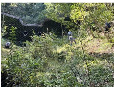
南谷堰堤付近での草刈り
