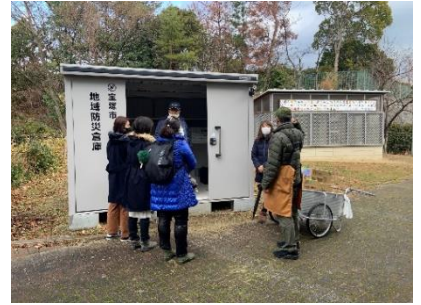
防災倉庫前での説明
