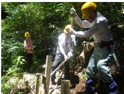
連絡道の土留め
