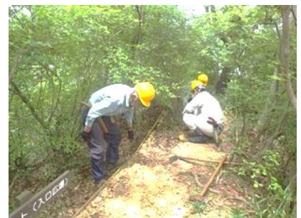
中央分岐付近の土留め
