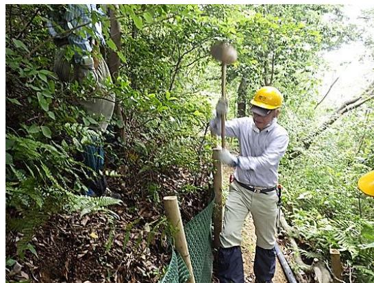
初めての杭打ち作業
