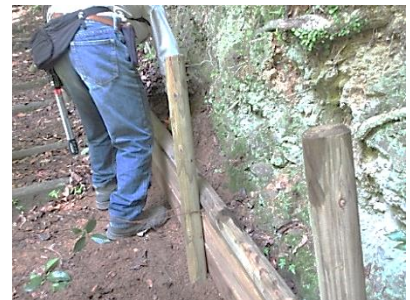
06/12 土砂崩れ防護柵の設置
