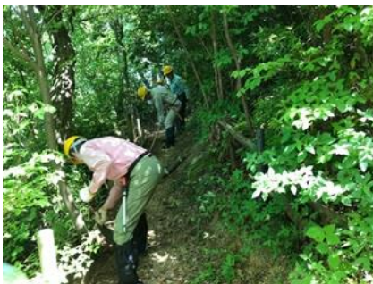
5/5 園路の土留め作業
