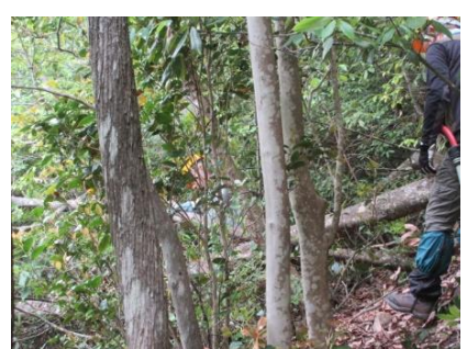
園路を支障している枯木処理
