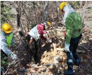
ゆずり葉ピーク～キツネの森 入口間で階段と路肩の改修
