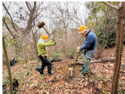
プラ階段の設置
