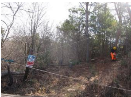
赤松休憩所: 枯松伐採ロープで牽引
