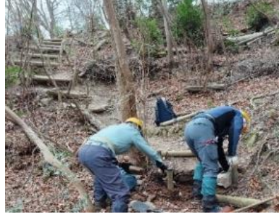
光ガ丘ルート第二丘奥の階段を改修
