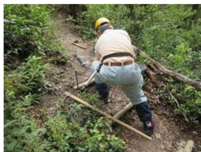
作業道階段の改修 鉄筋杭打ち込み
