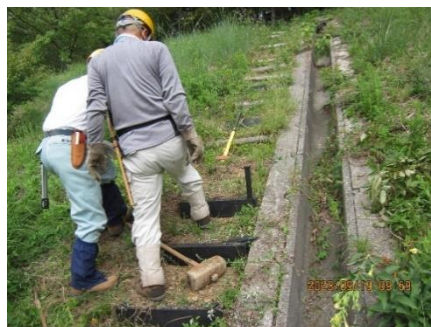
南斜面；作業階段補修
