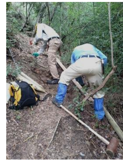
県宝谷平で路肩の 改修と階段追設
