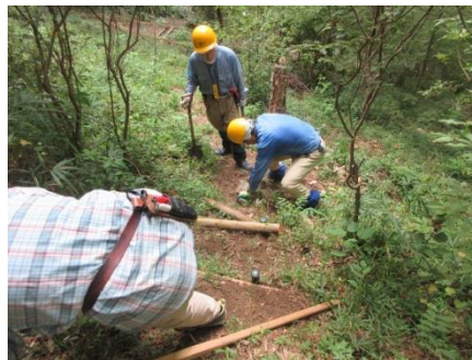
桜の尾根への作業道階段整備
