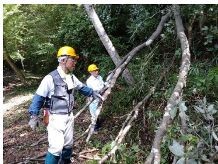
廃線跡 イヌエンジュ倒木処理
