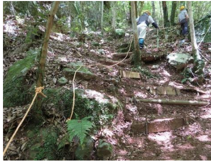
7/23 瀧見の道、階段部にロープ設置
