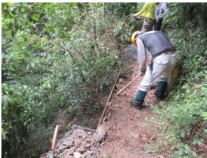
8/11 瀧見の道、路肩補修作業
