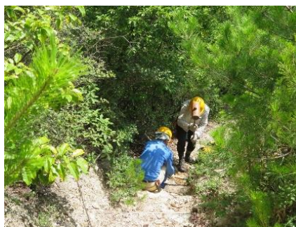
支多々川沿い行者山登山路小林堰堤付近の階段改修
