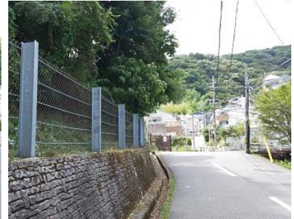
北側道沿い作業後
