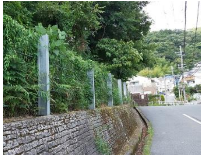
北側道沿い作業前
