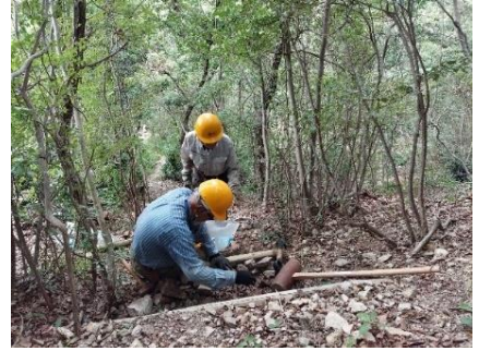
キツネの森への上り坂階段の改修
