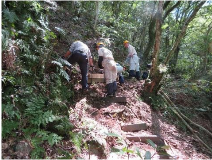
7/23 瀧見の道 崩落部の路肩整備
