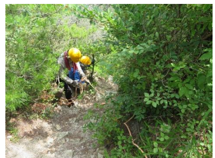
支多々川沿い行者山登山路小林堰堤付近急坂の安全ロープ更新
