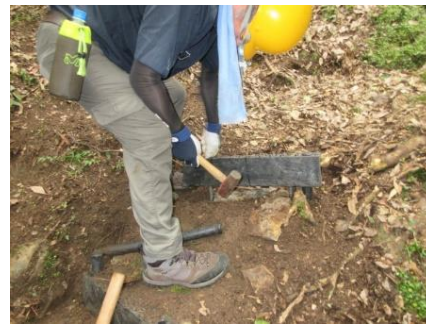
7/5 滝見の道 階段新設
