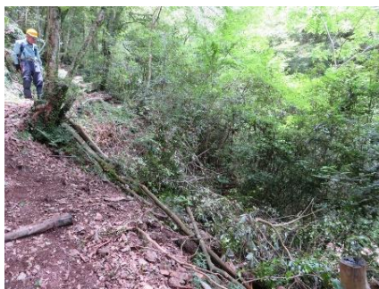
6/25 滝見の道 崩壊現場の点検
