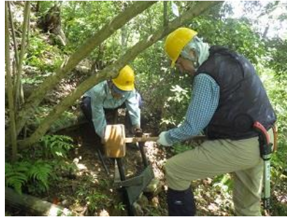
プラ階段の設置
