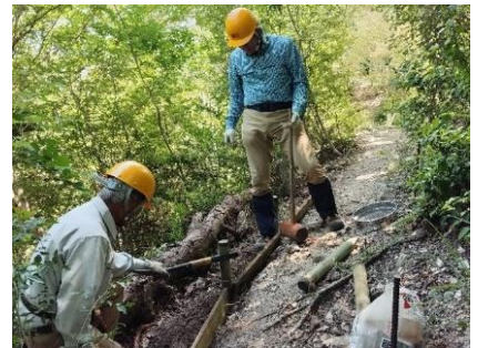
北逆瀬台、路肩の改修
