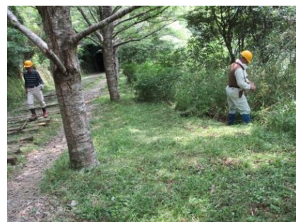
長尾山第二トンネル手前部 手鎌などで草刈
