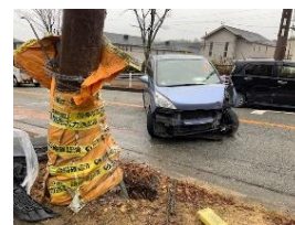
↑事故により破損した電柱
