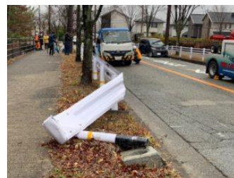
破損したガードレール
