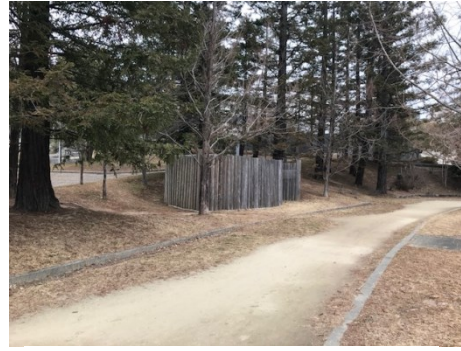
林の中のポンプ室 中には緑の回廊の草刈り機等 機材が保管されている
