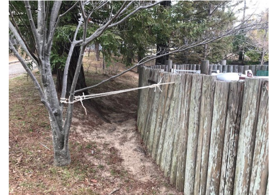
まとまって倒れて来た部分は ロープで倒れ防止をしている
