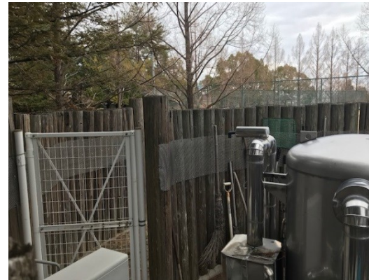
1本ずつだと倒れるので内側で 金網ネットで固定してある
