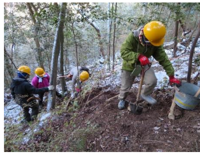
1/29 作業道の階段新設作業
