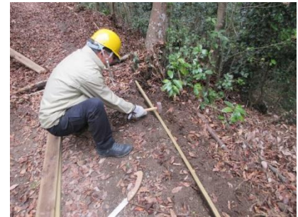
2/16 桜の道イノシシ被害の路肩補修
