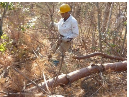
陽光広場の小林大堰堤上斜面 枯れ松伐採
