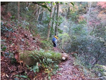
11/27 内周路・サクラの折れた幹を園路上から撤去
