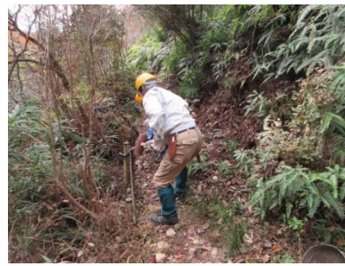
県宝谷平・路肩改修
