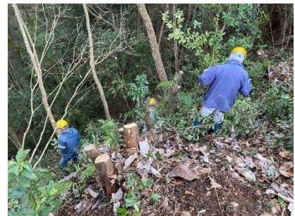
12/9 城ヶ丘広場谷側斜面の常緑樹伐採
