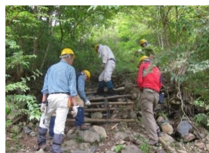
8/28 親水広場／河畔間 斜面で階段改修
