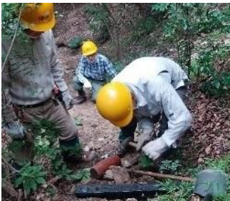
光が丘ルート路肩の改修
