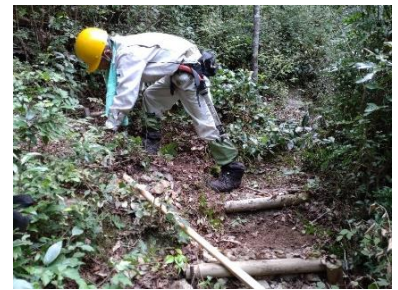
9/14 コナラ林で階段と路肩の補修
