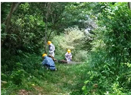
光が丘ルート路肩の改修
