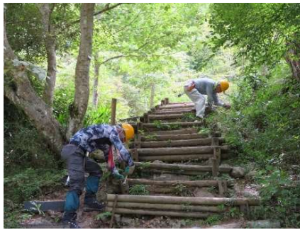
8/12 親水広場階段補修
