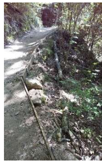
8/3 桜坂路肩補修
