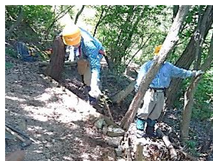
光が丘ルート路肩の改修
