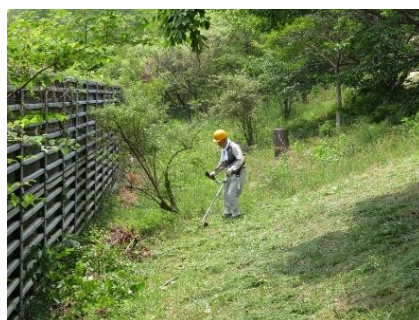
小林南大堰堤上斜面の草刈
