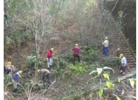
堰堤付近の常緑樹処理
