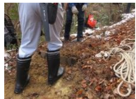
遠見の道階段増設
