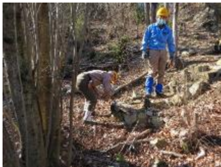
光が丘ルート階段の補修
