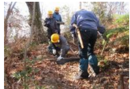
つつじが丘下の階段新設
