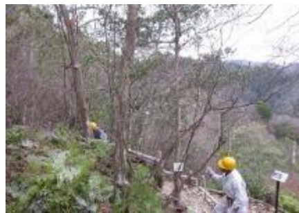
赤松道ビューポイント周辺整備
