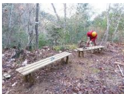
城ヶ丘 ベンチ据え付け
