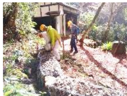
隔水亭 : 蛇籠積み
