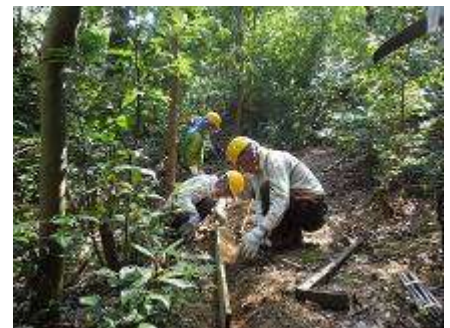
中学校下の園路補強
