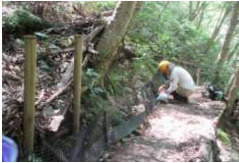
土留めプラネットの補修作業
