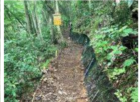
モミジの道 土留めトリカルネットを敷設
