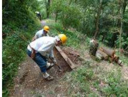
桜坂 倒木で傷んだ路肩の補修
