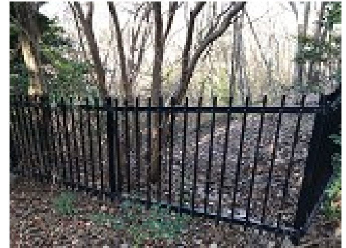
公園と住宅街、私有地を区別するアルミ柵があります
