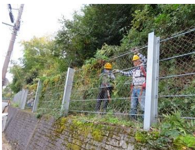
北側のフェンス沿い草刈り
