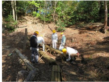
林間広場ベンチ設置 (11/5)
