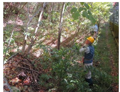
11/3 立体駐車場駐との間の 斜面で笹刈り
