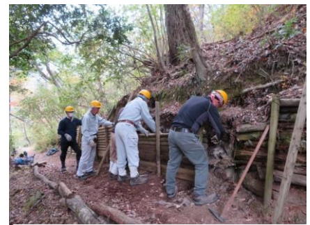
桜坂土留め改修 (11/13)
