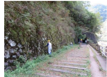
西宮との境界付近トンネル手前で草刈
