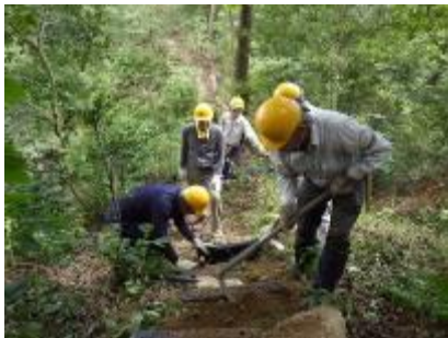
プラ階段の設置作業
