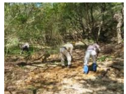
白瀬川第三堰堤上平・ 園路の修復作業
