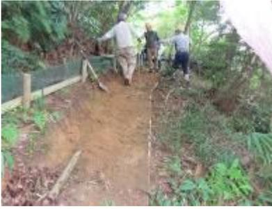
杉板による土留めの試験施工
