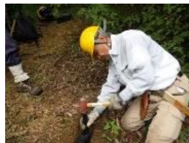
階段を固定するための杭打ち
