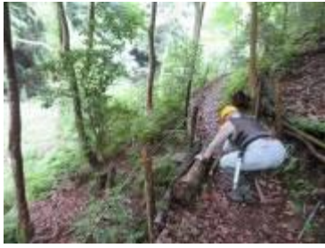
6/28 もみじの道の路肩補修
