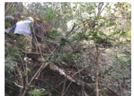
南谷堰堤上部倒木処理
