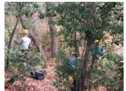
南谷堰堤上で常緑樹除伐
