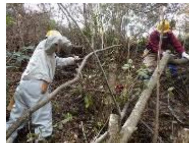
赤松展望所 ヤシャブシ伐倒後の処理
