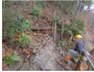
湧水路脇の土留め工事
