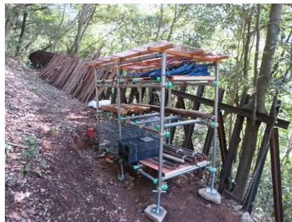
遠見口に資材保管棚設置
