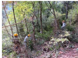
桜坂上部東斜面で常緑樹伐採
