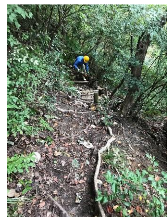
北逆瀬台口への上り階段の補修
