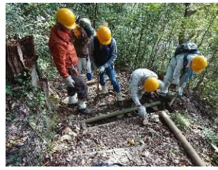
大峰道で階段補修
