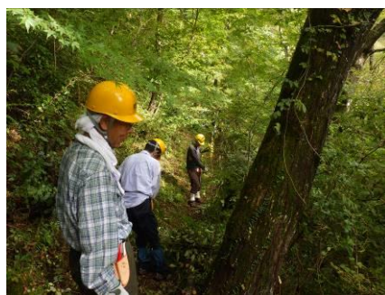
桜坂上部東斜面で間伐作業
