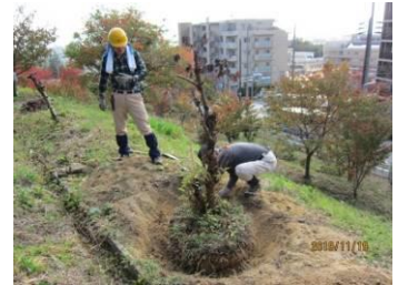
南斜面 枯死桜の掘り起し
