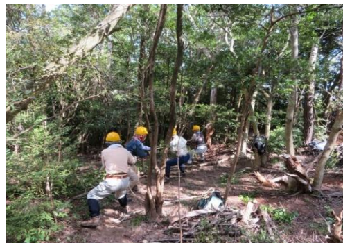
西逆瀬台口へのバイパス入口での倒木処理
