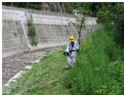
入口歩道橋上流側： ササバザクラ植樹地急斜面で草刈
