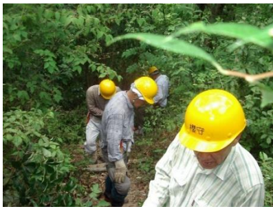
桜坂～桜の尾根間作業路交差付近の整備
