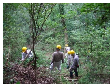
桜坂～桜の尾根間作業路の整備
