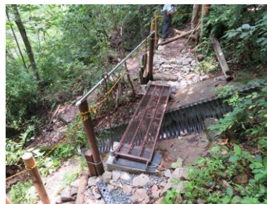
湧水路上に架設した新しいスチール製の橋
