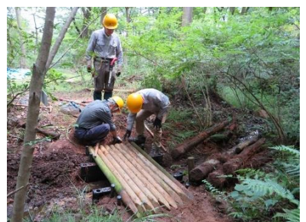
広場西南の橋の架け替え
