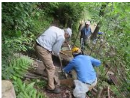
新橋用基礎のコンクリート打ち
