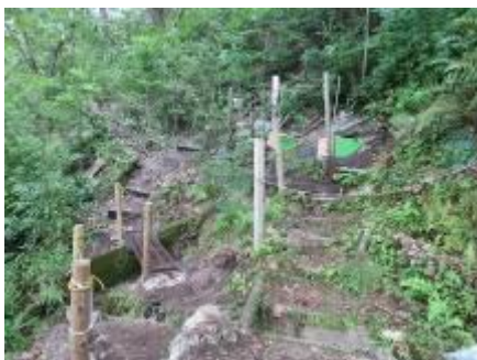
仮設道(左下)と新橋の基礎(右上)
