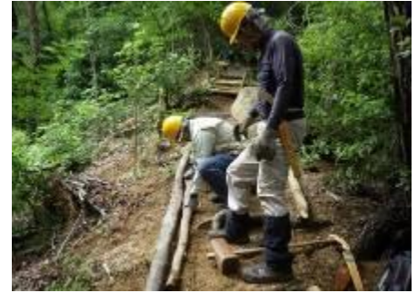
塩谷道沿の土留め
