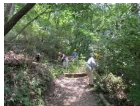
桜坂上部 間伐材処理
