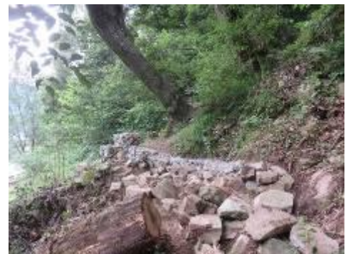
崩落サクラ周辺 蛇籠設置
