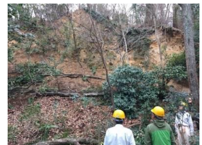
武庫山道の崩落崖土留めを
