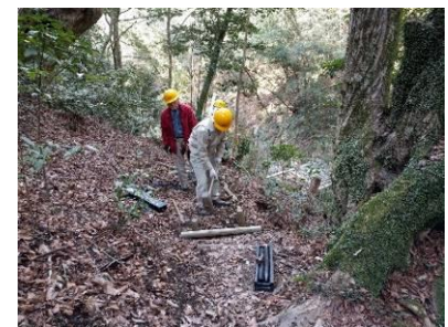
どんぐりの道 階段整備
