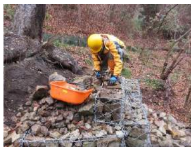
蛇籠への石詰め作業
