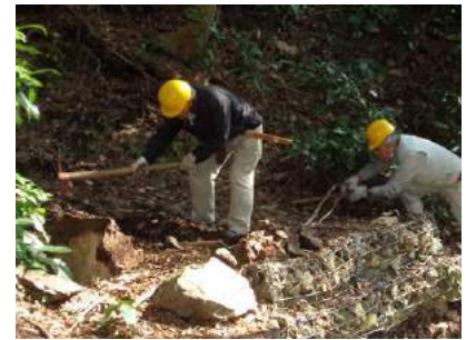
蛇籠上部の清掃作業
