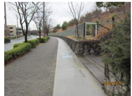
側溝の工事が完了した歩道
