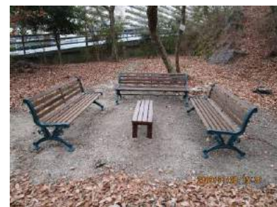
修理を終えたゆずり葉の森の広場の テーブルとベンチ
