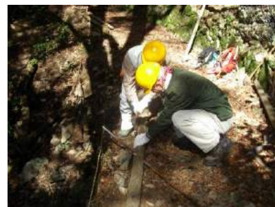
階段の補修整備
