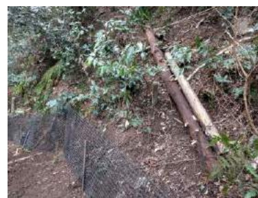
山側の土留めの設置
