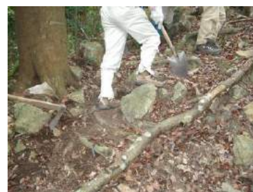
路肩と階段の補修
