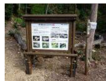
林間広場 環境学習用掲示板取付
