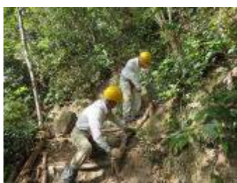
大峰道・路肩の修復
