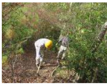
ヤッホー広場への作業道整備
