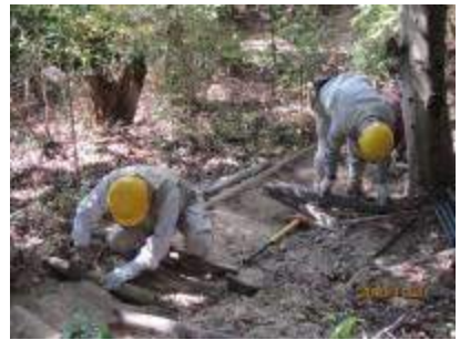
里山こみち 園路補修中
