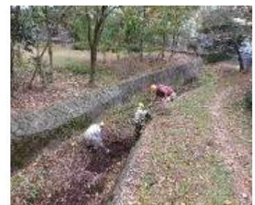
桜の根元養生用の土の掘り起し
