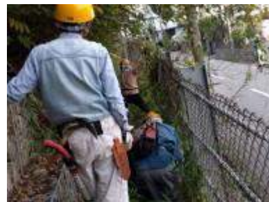
北側フェンス沿い除草
