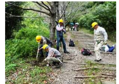
看板穴掘り作業中
