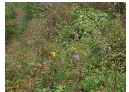
桜周辺の除伐作業
