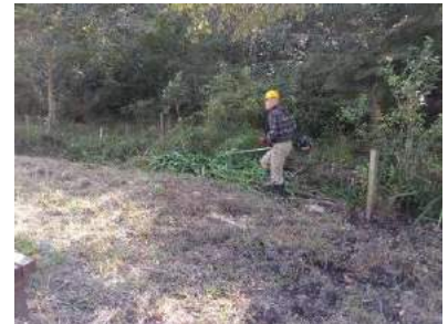
倉庫前広場処理
