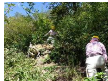
桜の尾根、除伐作業
