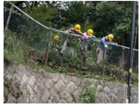
入口付近フェンス除草
