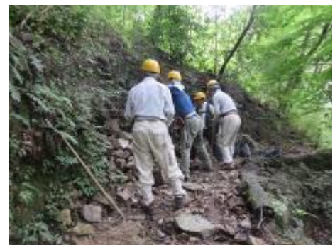
コナラ林からの落石の整理(隔水亭上園路)
