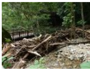
エントランス広場下堰堤 流木の堆積
