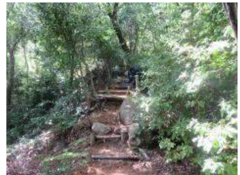
塩谷ルートの階段整備
