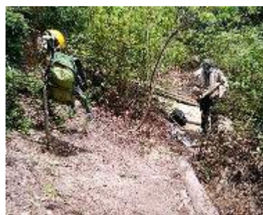
重い丸太を崩落跡まで運び上げた
