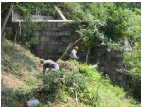
南斜面 ハリエンジュの伐採処理
