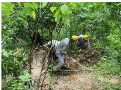
環境学習用作業道の復旧
