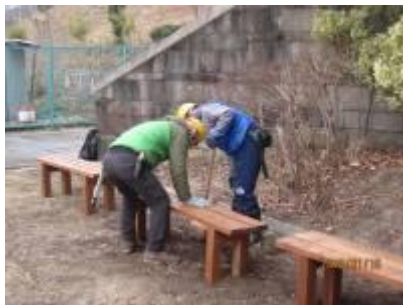
集合広場でベンチ設置中
