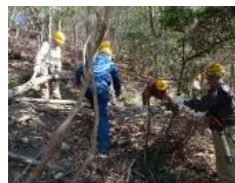
伐採木での路肩整備 (外周路)
